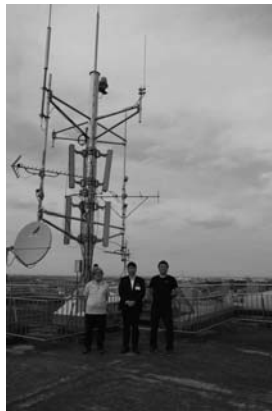
図6 2024年狭山市との協働事業で市庁舎屋上にアンテナを設置
