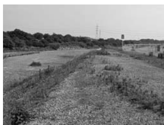
図4 入間川上奥富堰周辺の河道変更工事、河岸林を全て伐採／図5 河道を直線にする
