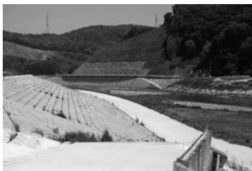
図1 小田川の高梁川合流点を堰き止め下流部に付け替える
